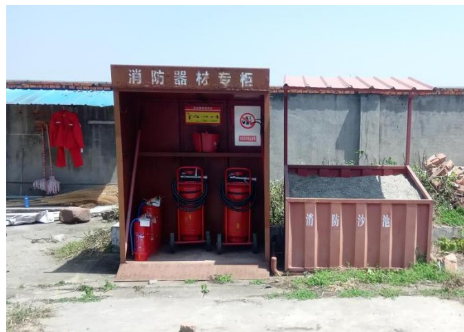
消防器材及消防沙池
